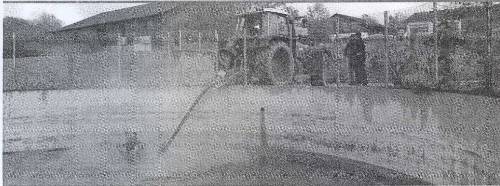
Entlang des Rührwerks wird der Schlauch in die Gülle gelegt. Dadurch wird der eingeblasene Kalk sofort in der Gülle gleichmäßig verteilt. Voraussetzung ist, dass ein 40-Tonnen-Lkw die Grube anfahren kann. Fotos: Piller
