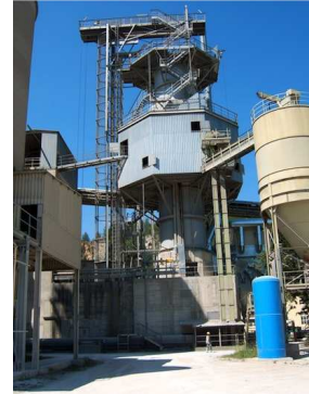
Hochofen zur Herstellung von Magnesium Branntkalk
